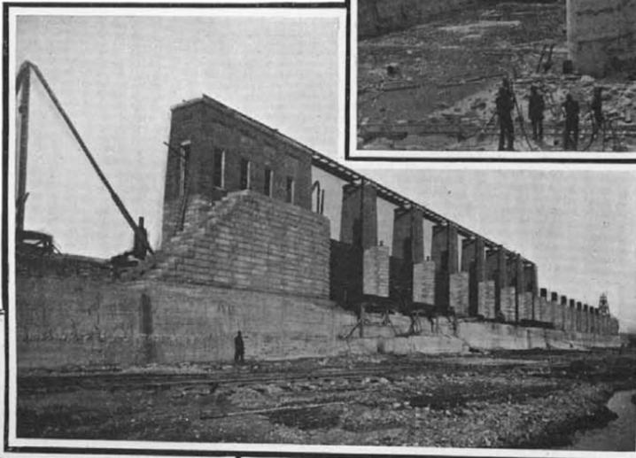
CONSTRUCTION OF STONEY GATES AT CONTROLLING WORKS.
