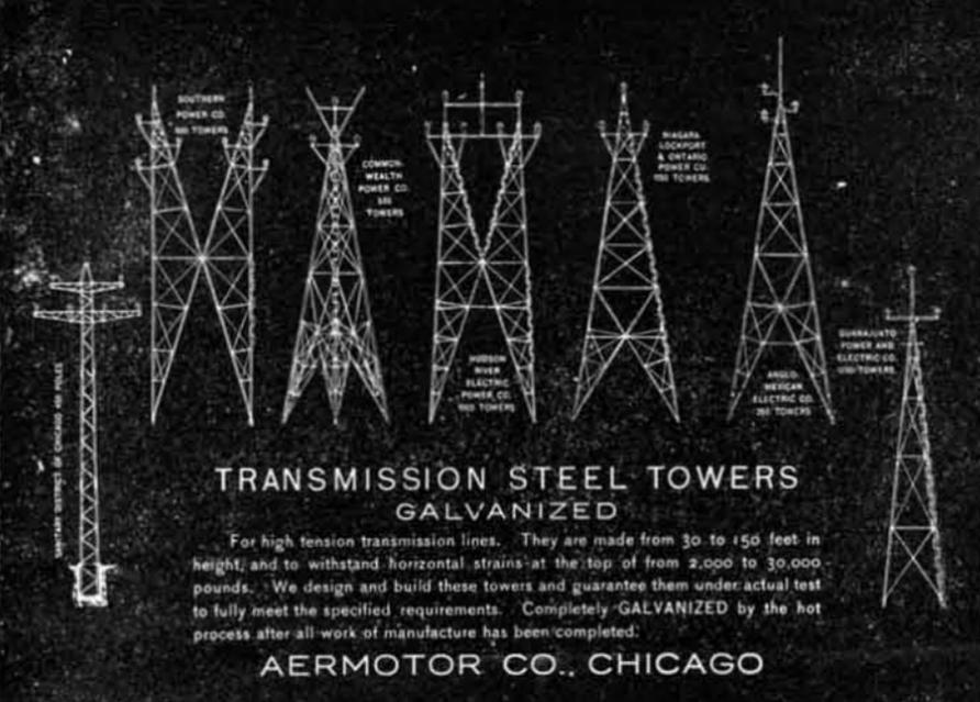
**TRANSMISSION STEEL TOWERS GALVANIZED**
