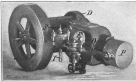
DOUBLE-PISTON GASOLINE MOTOR.
