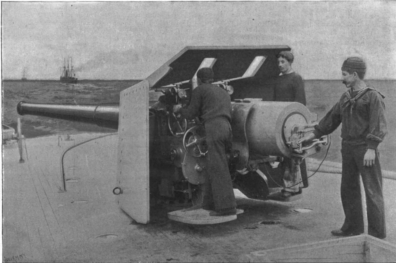
Fig. 4.—SIGHTING A 6-INCH RAPID-FIRE GUN BREECH CLOSED.
