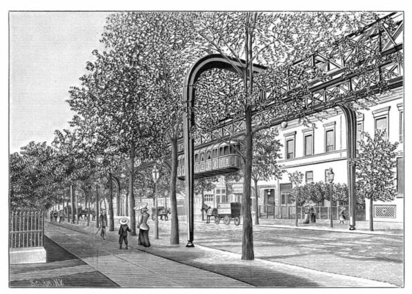
Fig. 6.-PROJECT FOR AN ELECTRIC SUSPENDED RAILWAY FOR BERLIN.
