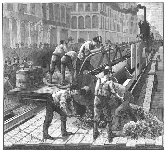
POWER CONCRETE MIXER-CAPACITY, 15 CUBIC YARDS PER HOUR.
