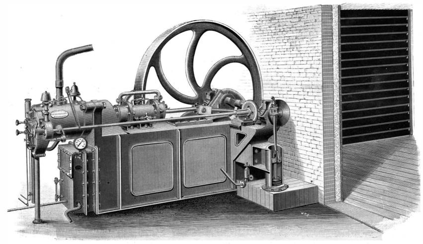
COMBINED GAS MOTOR AND REFRIGERATOR.
